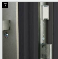
Zasuwnica GU Secure Automatic z blokadą klamki
