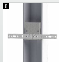
Elementy wzmacniające konstrukcję ościeżnicy z kotwami montażowymi
